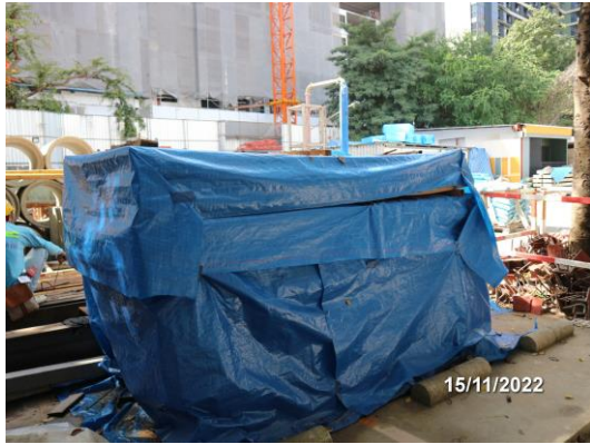
รูปที่ 3-11 ปิดคลุมวัสดุที่อาจก่อให้เกิดฝุ่น
